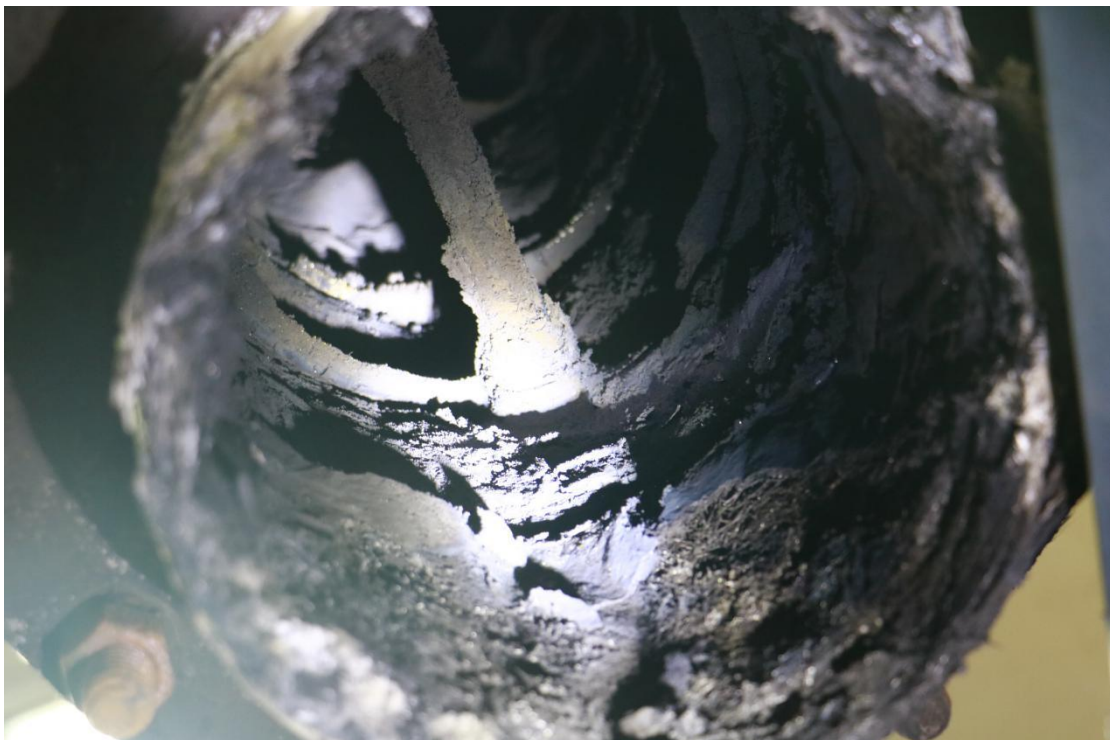
马弗炉顶部玻璃钢管内部细节
