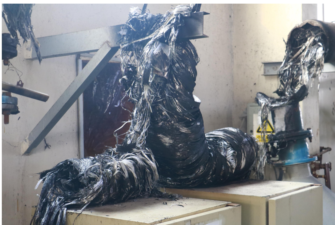
部分塌落玻璃钢管道
