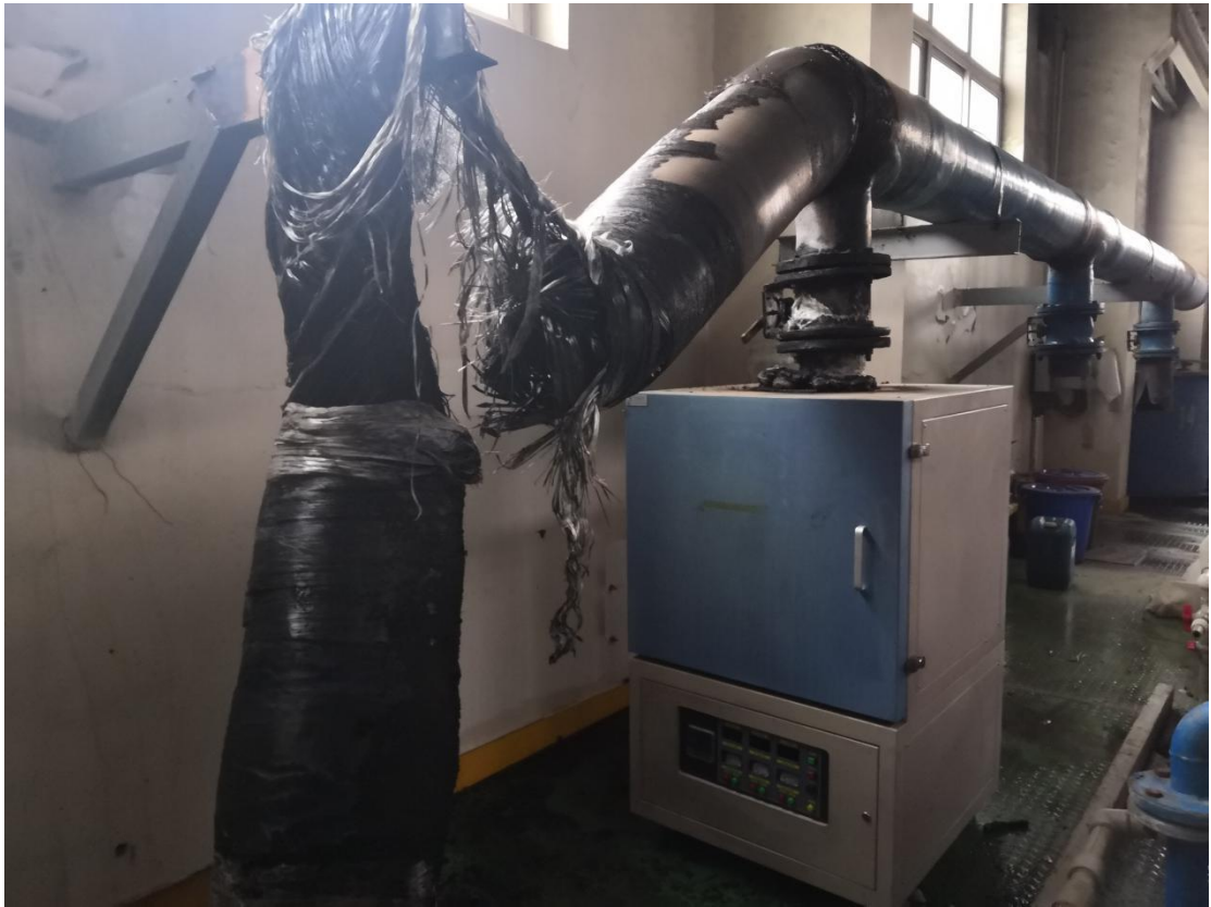
马弗炉及烧毁的部分玻璃钢管道
