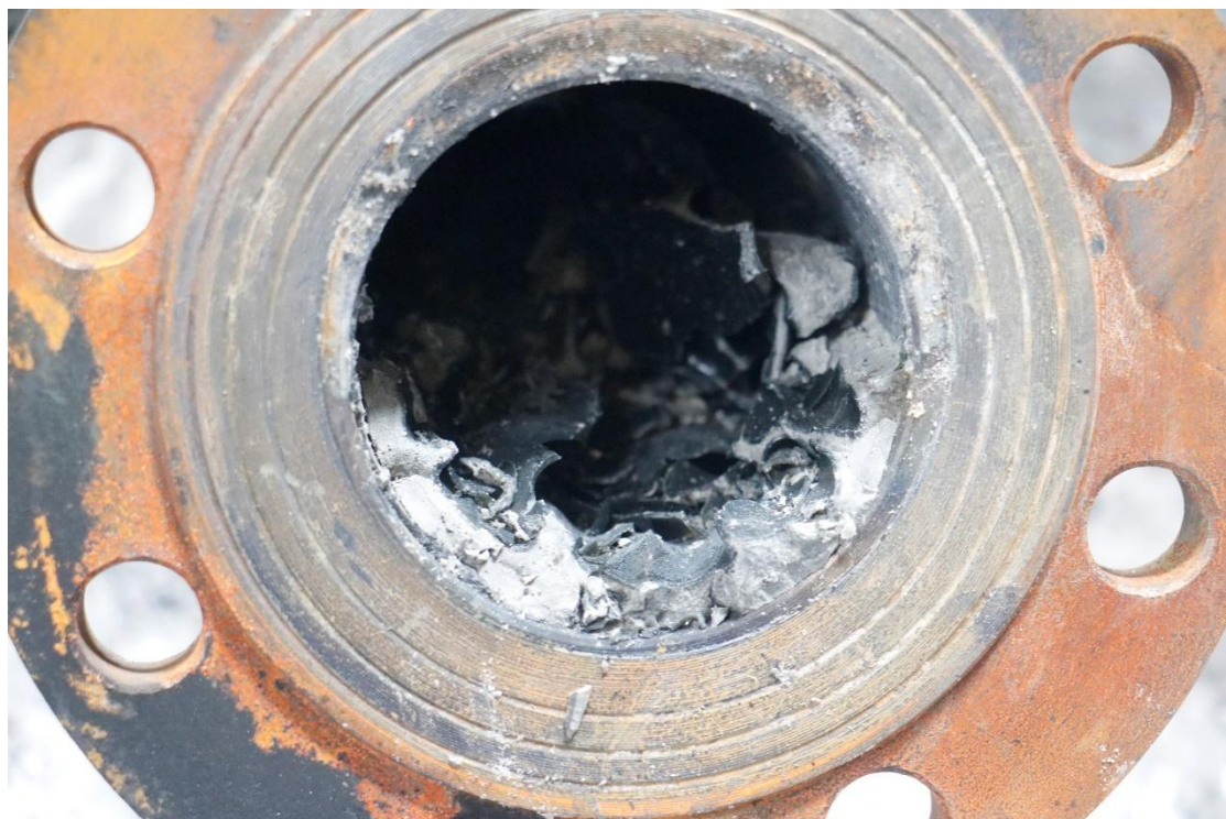
3#压滤机进料管内残留物
